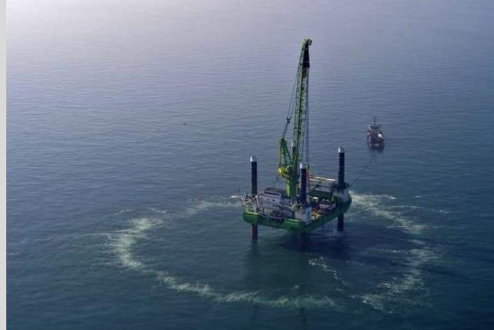
"Bubbelgardinen" är en "vägg" av luftbubblor, de används i byggandet av vindkraftverk för att minska undervattensbuller.
